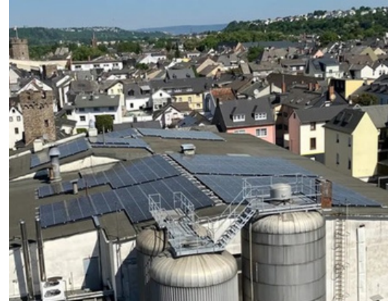
Die mit PV-Modulen belegte Dachfläche der Lahnsteiner Brauerei.
